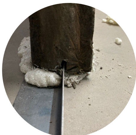
Fixação em perfil metálico
