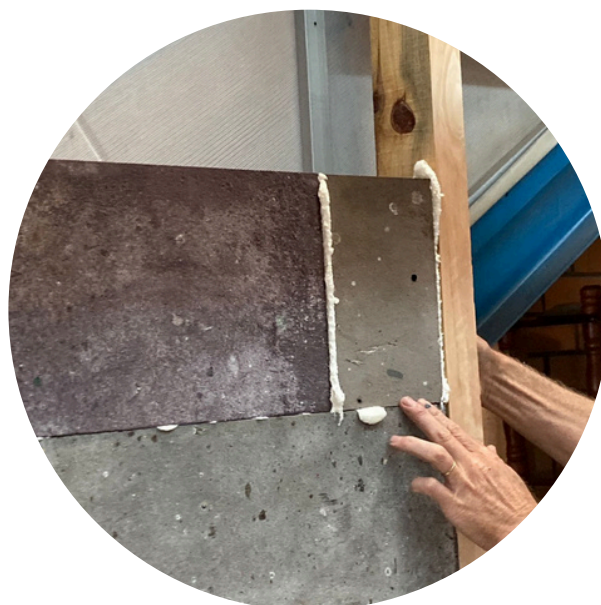
Colagem dos blocos na interface com estrutura de madeira
