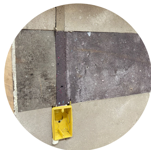
Infraestrutura Elétrica com recolocação de parte dos blocos.
